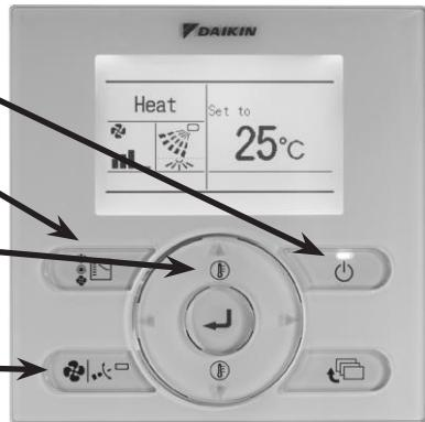
1. Encendido o apagado del aparato: la luz roja indica que el aparato está encendido
